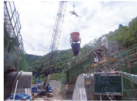
⑮ 減勢工打設状況(H25.7)
