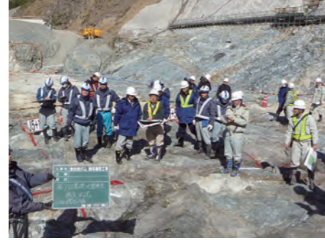
⑧ 基礎地盤検査(H25.3)
