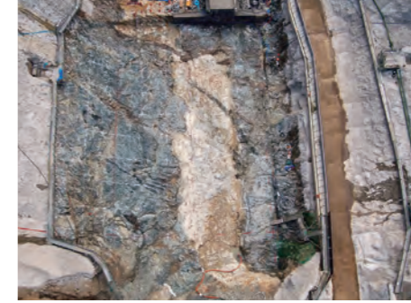
⑪ 仕上掘削状況(H25.4)
