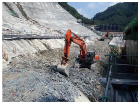
⑲ 右岸2次掘(H25.8)
