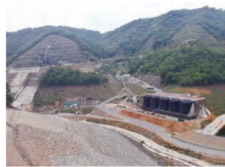
⑭ 仮設設備全景(H25.6)
