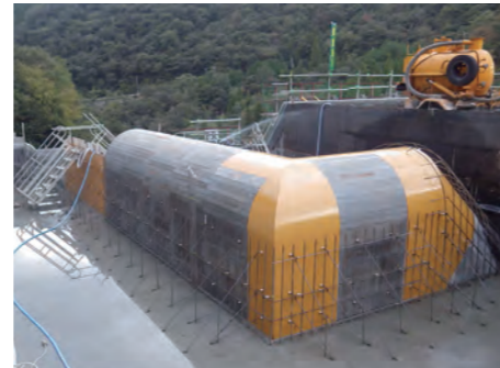
③⑩ 監査廊型枠設置状況(H26.10)
