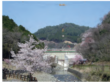
②⑤ 堤体コンクリート打設状況(H26.4)
