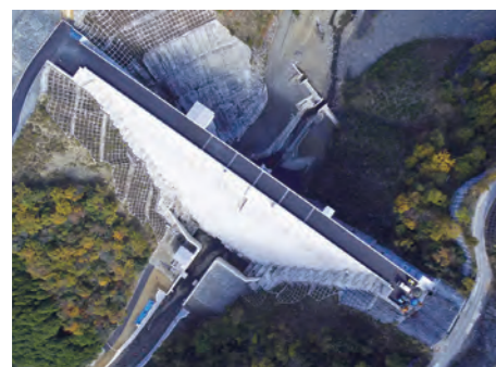
③⑥ 試験湛水前堤体垂直写真(H27.11)
