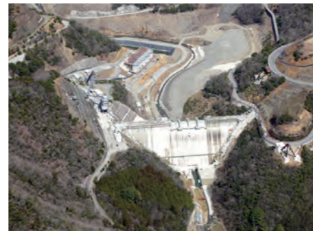
③③ 堤体打設完了全景(H27.3)
