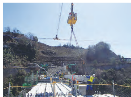
③④ 天端橋梁架設状況(H27.4)
