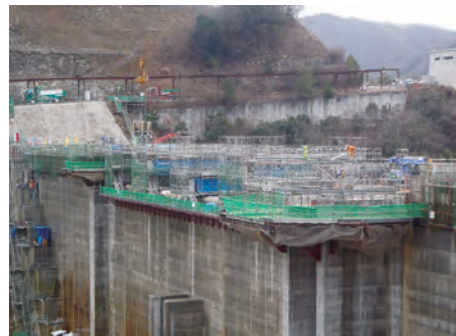
③① 高標高張出部施工状況(H27.2)
