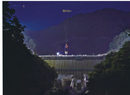
②⑧ 夜間打設状況(H26.7)
