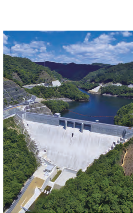
③⑧ 完了全景(左岸下流より下流を望む)
