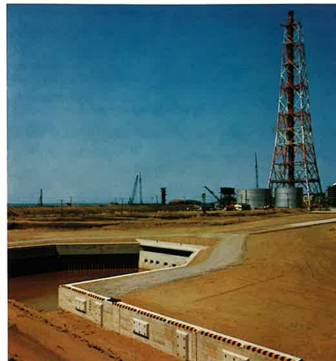
福井共同火力発電所放水路工事＝三国町（S52, 6）
