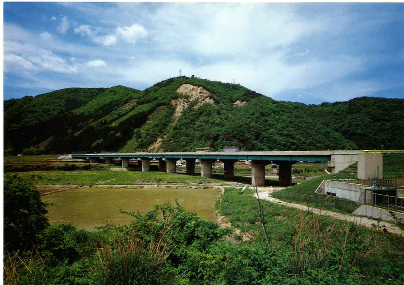
北陸自動車道日野川橋下部工事＝今庄町（S50.7）
