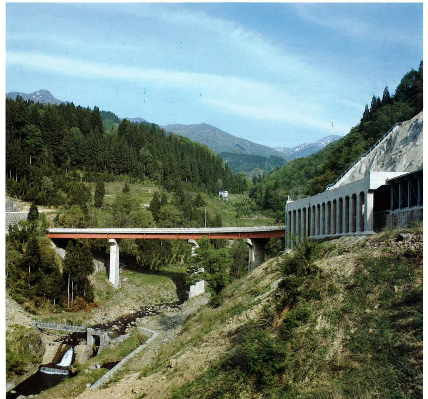
国道157号線 小原大橋下部工事及小原大橋床版工事＝勝山市 （S46.12） （S47.12）
