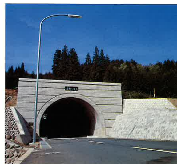
クレミトンネル工事＝勝山市（S55.3）
