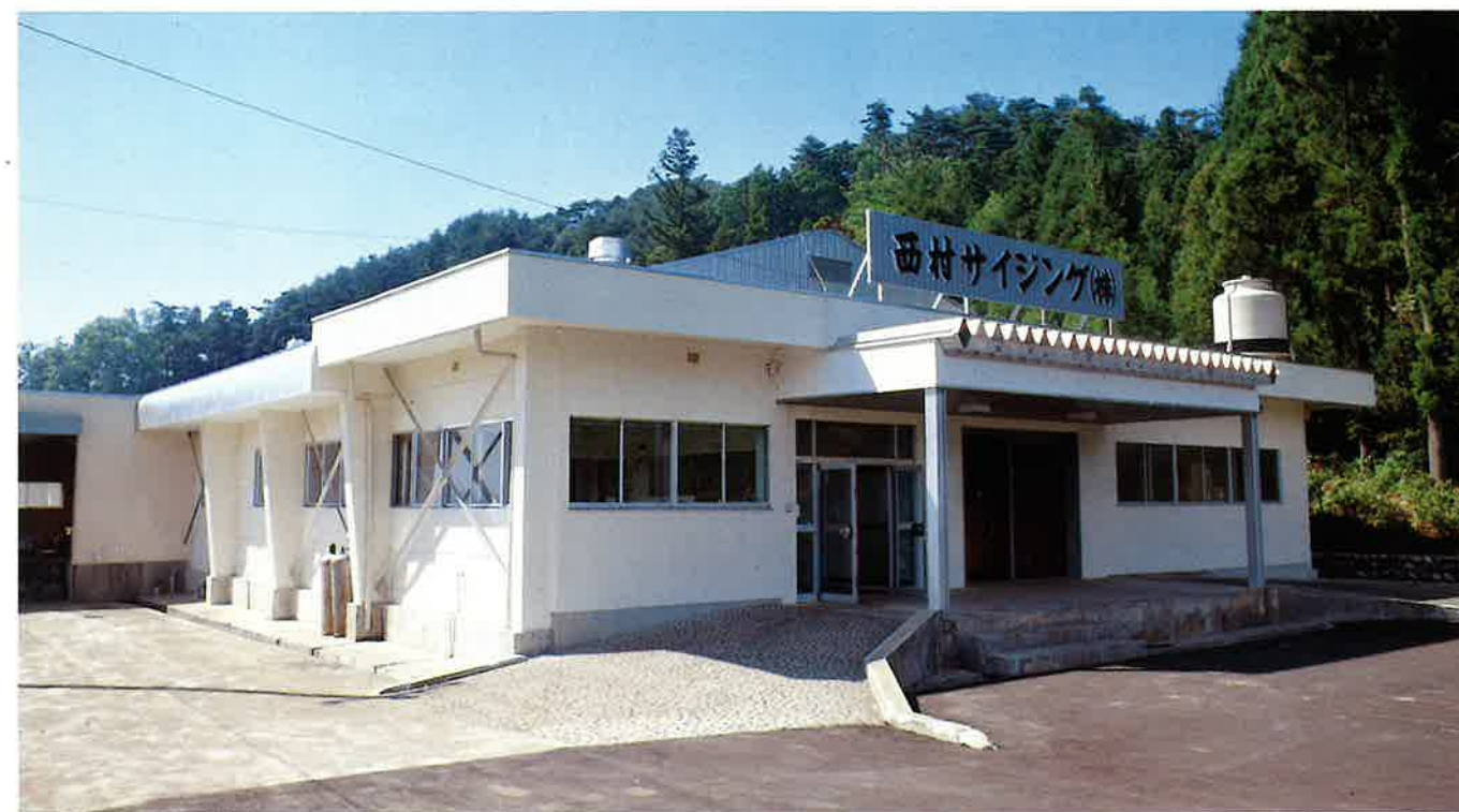
サイジング工場全景
