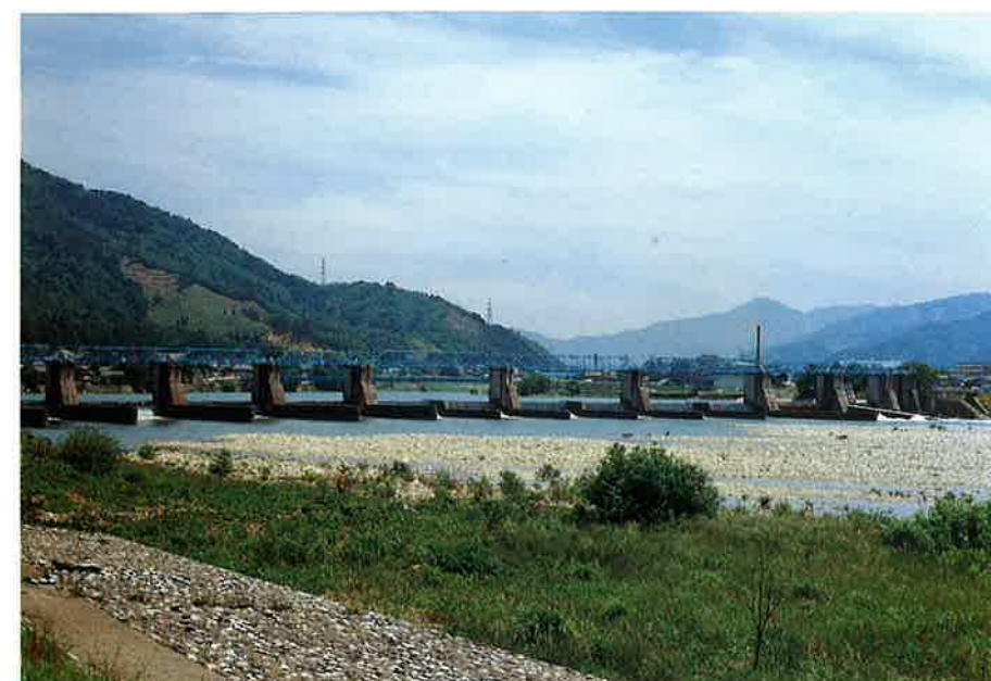
九頭竜川鳴鹿堰堤頭首工改良工事＝永平寺町（S41.3）
