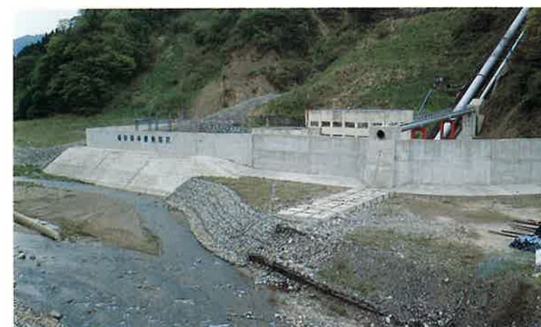
真名川中島発電所水没対策工事＝大野市（S52.3）
