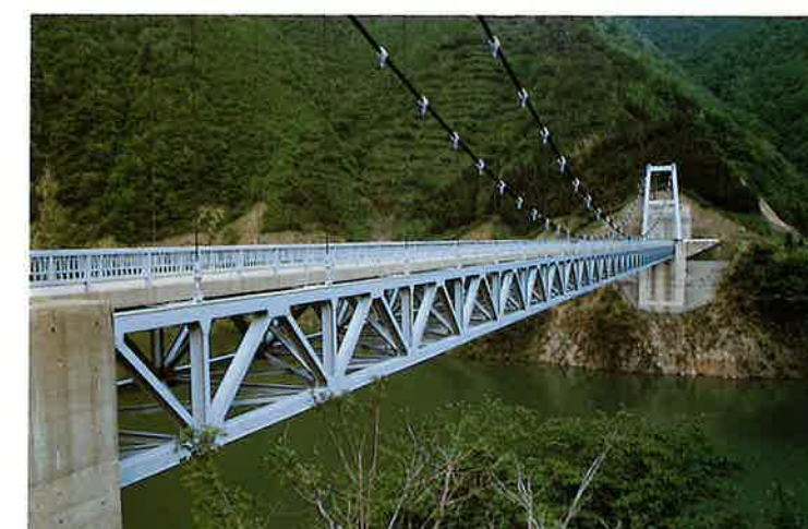
真名川ダム 若生子大橋下部工事＝大野市（S49.12）
