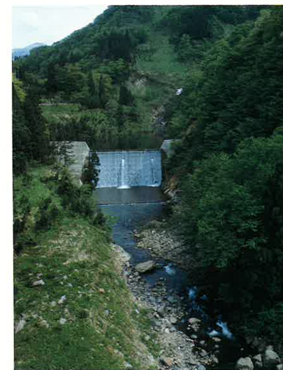
勝山小原砂防工事＝勝山市（S50.3）
