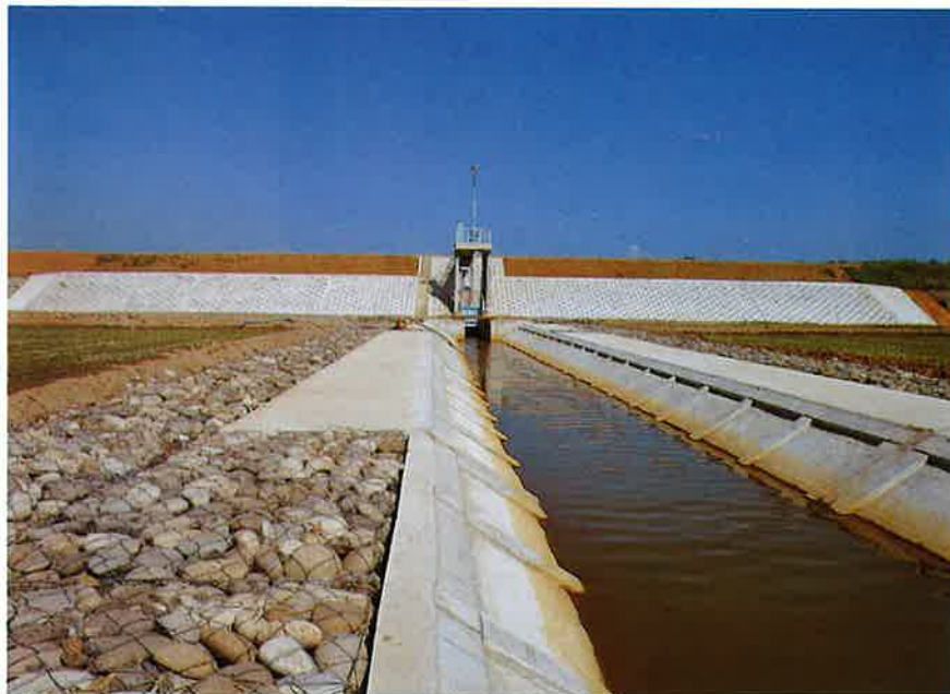
池見樋門改築工事＝三国町（S55, 3）
