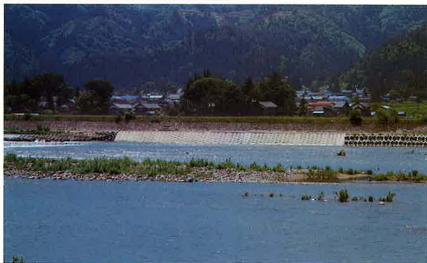
九頭竜川河川災害復旧工事＝永平寺町（S54, 3）
