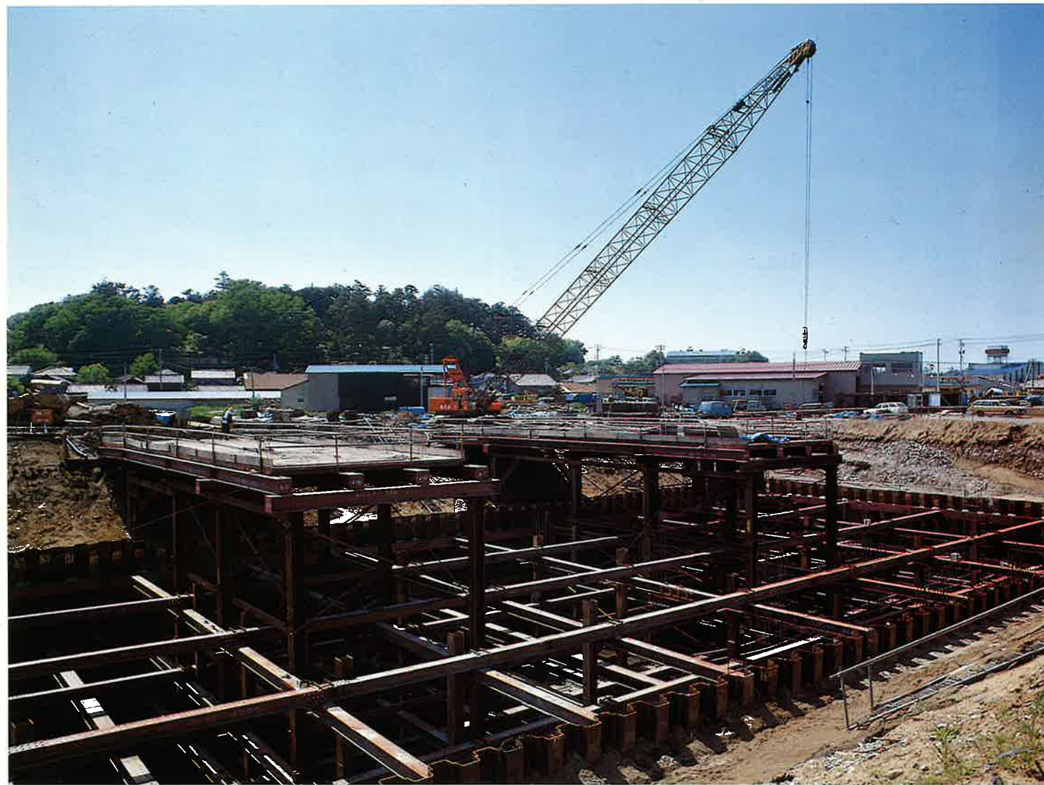
竹田川ポンプ場築造工事＝三国町（現在施工中）
