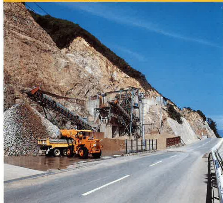
坂東島工場（プラント性能） 山砕石用 500 t/r - 1 基
