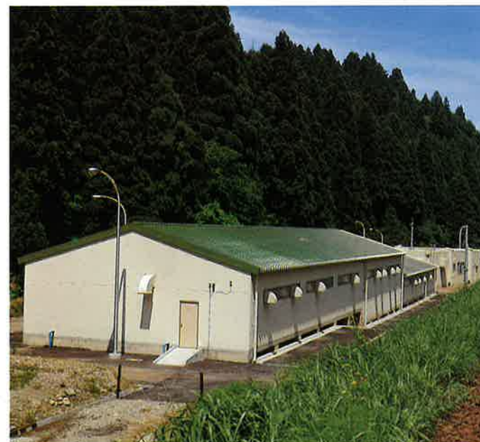
永平寺町志比浄化センター(土木)工事＝永平寺（S54.8）
