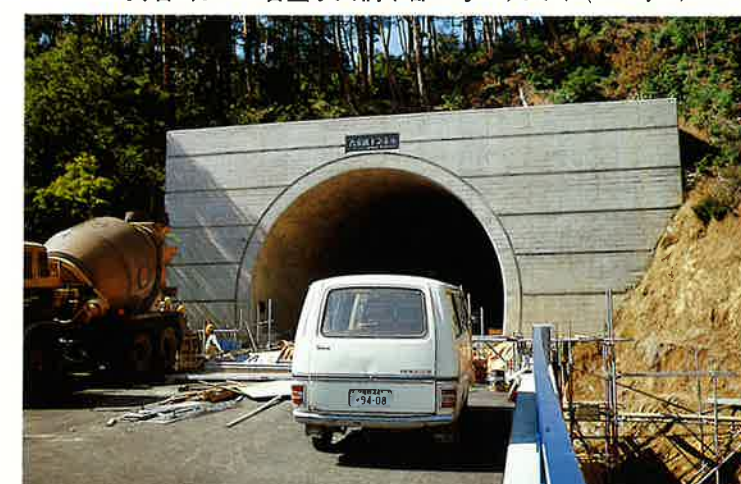
国道364号線六呂瀬トンネル工事＝丸岡町（S54.12）
