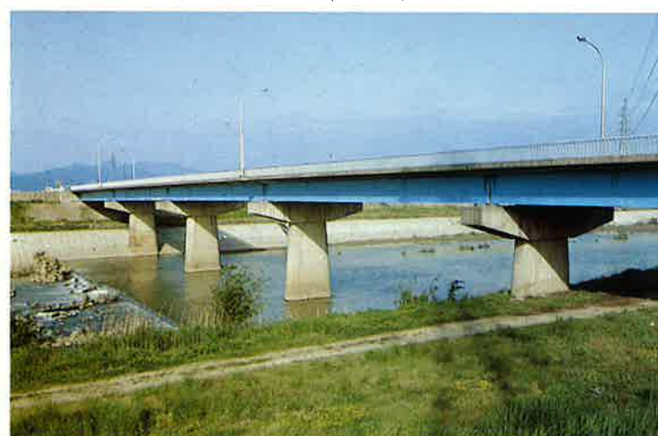
大瀬橋下部工事＝福井市（S45～48）
