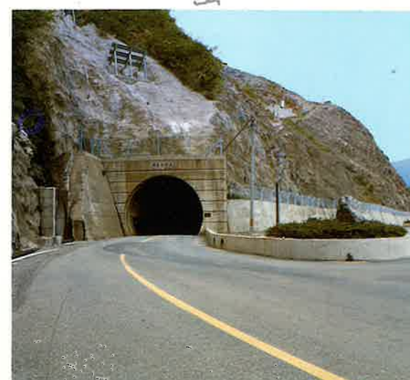
真名川ダム 若生子トンネル工事＝大野市 （S45.10）
