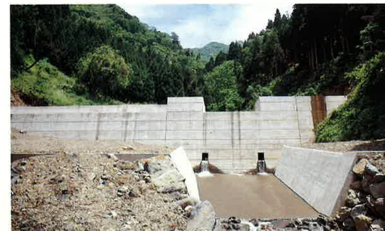
永平寺町栃原砂防工事（現在施工中）＝永平寺町
