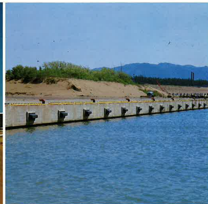
福井新港－ 7.5M岩壁工事＝三国町（S52, 12）
