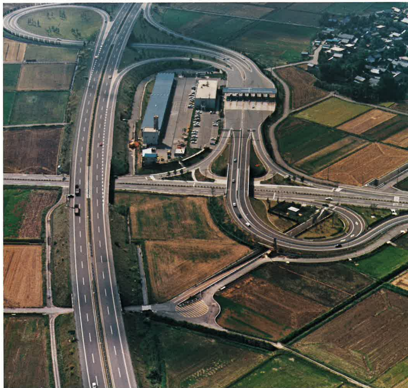
北陸自動車道福井第2インターチェンジ工事＝福井市（S53.3竣工）
