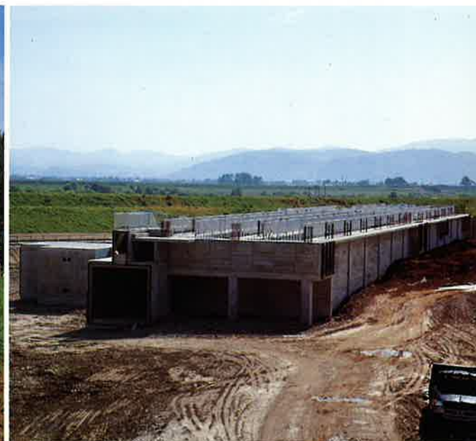
五領川浄化センター工事＝丸岡町（S53.9）
