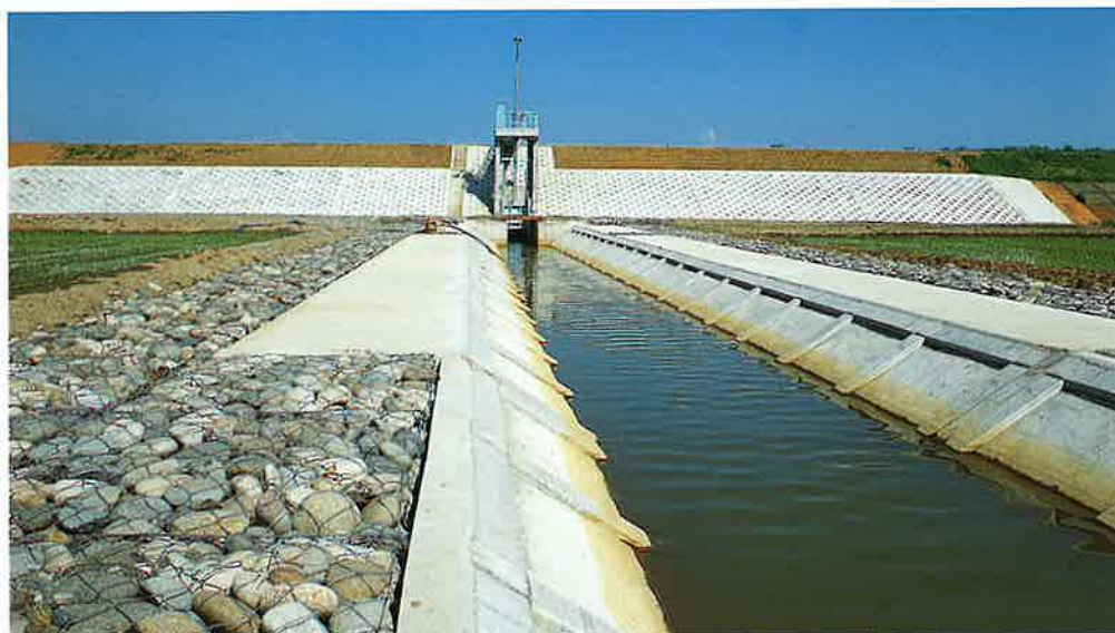
池見排水樋門改築工事＝三国町（S55.3）
