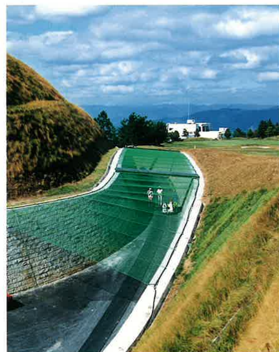
京浜バイパス宇治トンネル立坑工事用道路工事 ＝宇治市（S60.10）
