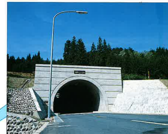
暮見トンネル工事=勝山市 L=557M (1980.3)
