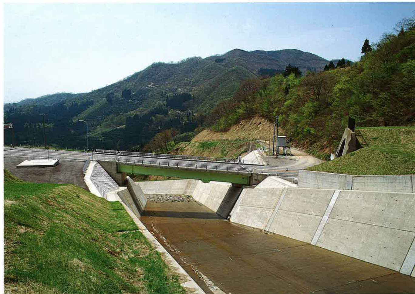
国道157号道路災害復旧工事＝勝山市（S62.11）
