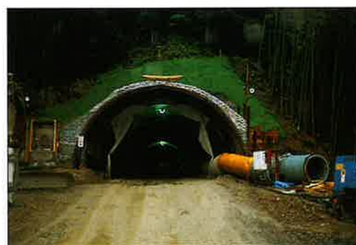
福谷第二トンネル工事=高浜町 (施工中) L=910M (ナトム工法)
