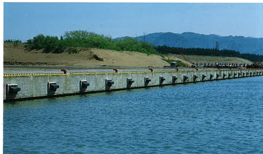
福井新港(-7.5m)岩壁工事 =三国町 (S52.12)
