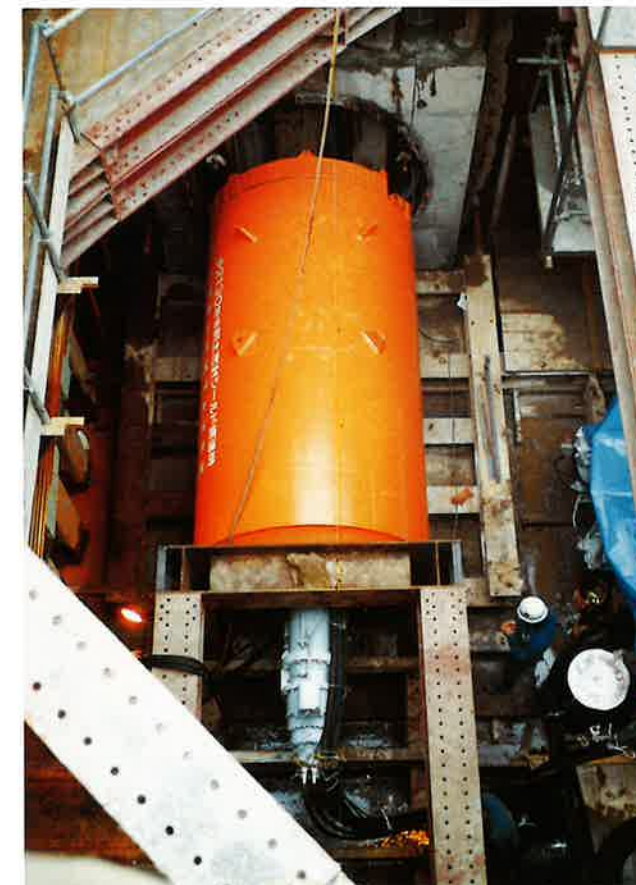
シールドマシン投入
