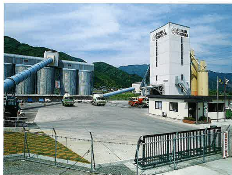
福井小野田レミコン(株)プラント建設土木工事＝永平寺町 (S63.5)
