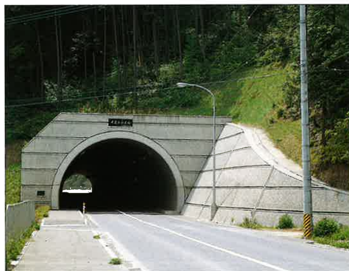
犬見トンネル工事=大飯町 L=220M (1986.10)
