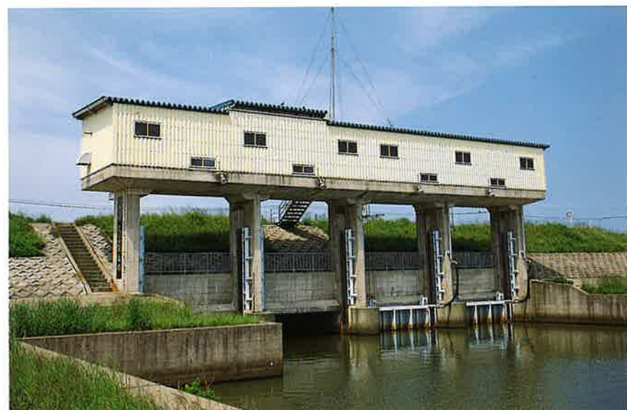
片川放水路樋門新設工事＝福井市（S58.3）
