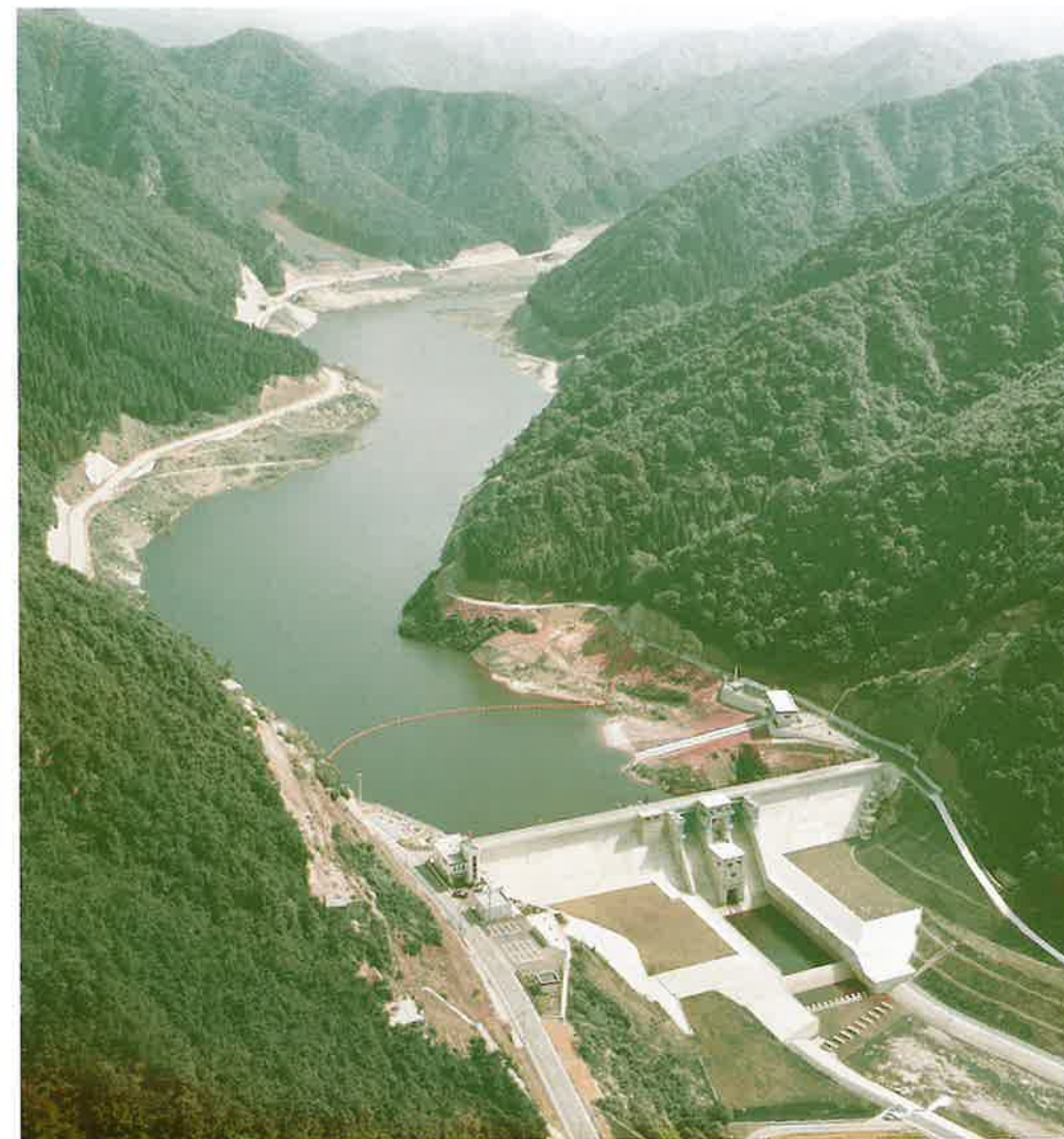
赤瀬ダム工事 ＝石川県小松市（S52.12）
