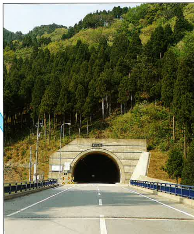
近庄トンネル工事=丸岡町 L=1186.4M (1986.12)
