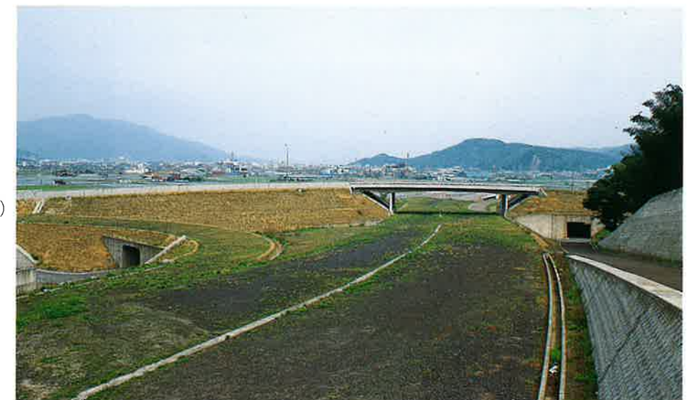
敦賀バイパス坂ノ下インター改良工事 ＝敦賀市（S58.3）
