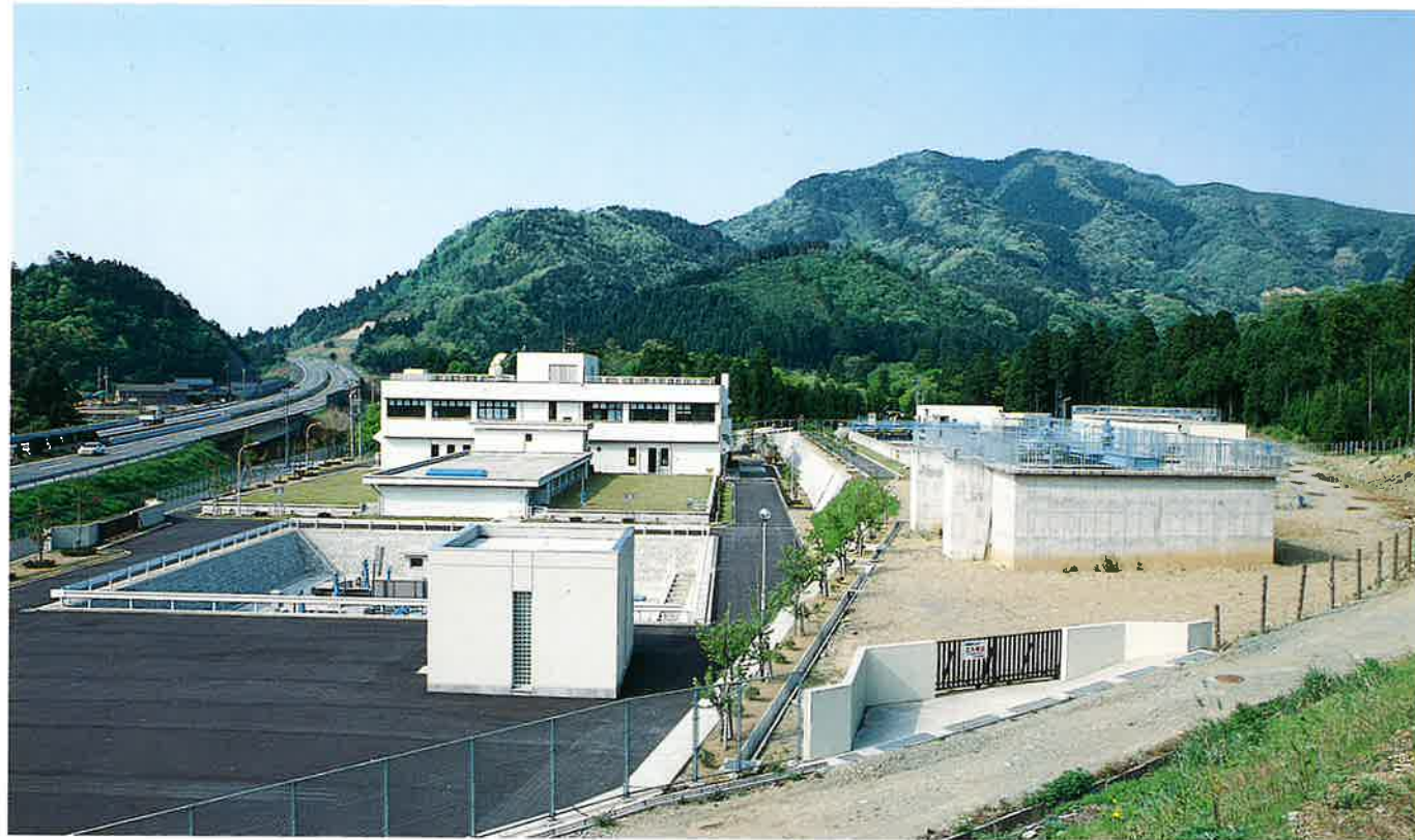
山久保浄水場工事＝金津町（S63.5）
