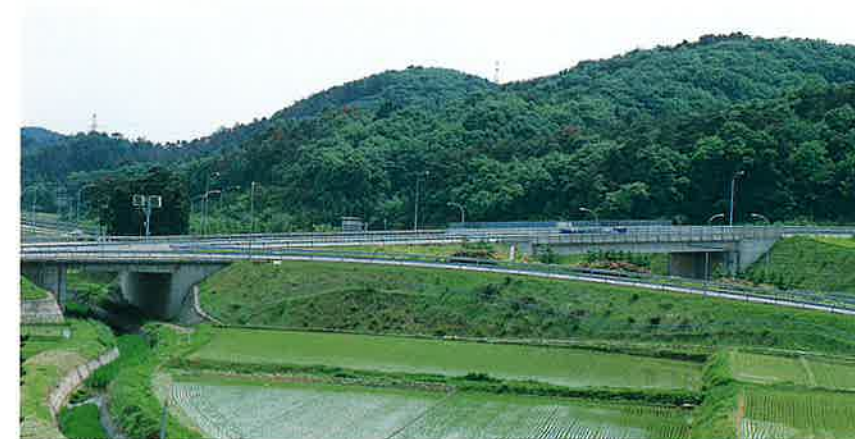
北陸自動車道金津インターチェンジ工事 ＝金津町（S58.12）
