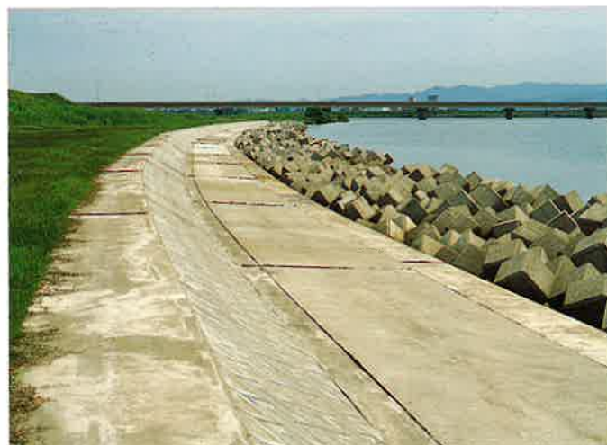
下野低水護岸根固その20工事＝三国町（S62.3）
