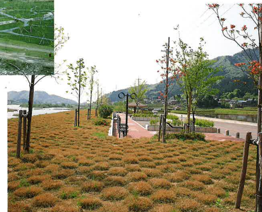
沿道スペース美化工事=永平寺町 (S63.3)
