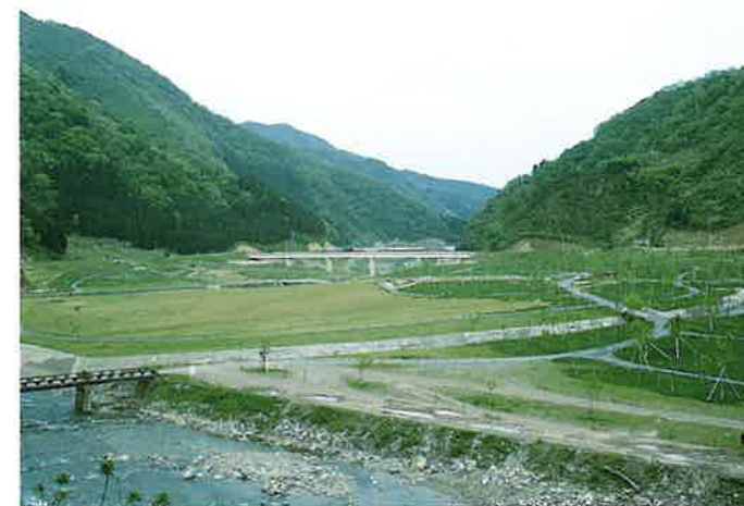
真名川中島地区造成工事=大野市 (S55.9)
