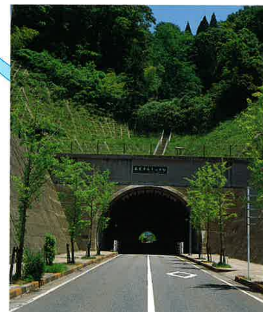
長泉寺山トンネル工事=鯖江市 L=300M (1983.11)
