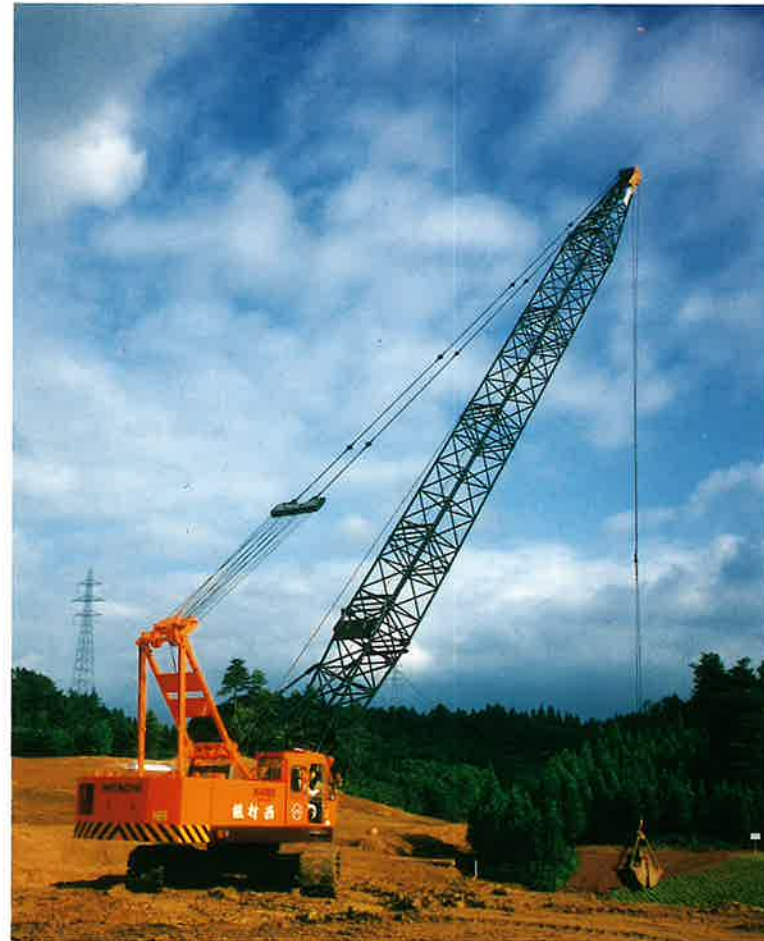
クローラークレーン
