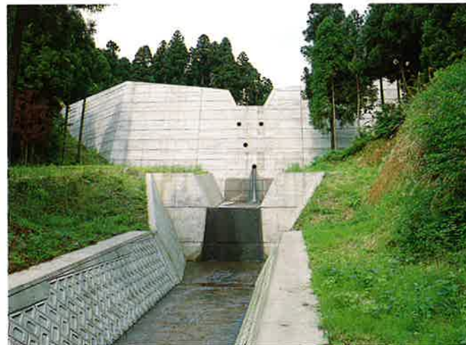
荒谷川通常砂防工事＝永平寺町（S63.3）
