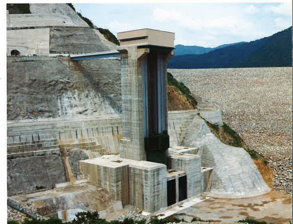
手取川ダム第一発電所取水塔 （スリップフォーム工法）工事 ＝石川県尾口村（S54.6）
