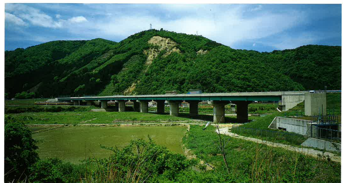
北陸自動車道日野川橋下部工事＝今庄町（S50.7）
