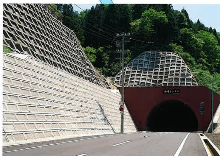
山中トンネル工事=越前町 (1989.3) L=430M (うち越前町側215M)
