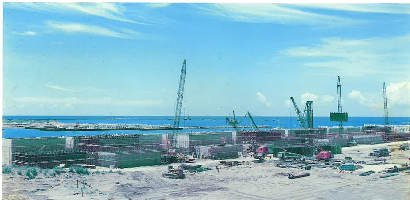
福井臨海工業地帯ケーソン製作工事=三国町 (S50.8)
