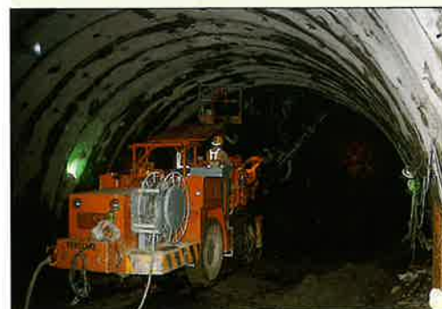
福谷第二トンネル工事=高浜町 (施工中) L=910M (ナトム工法)
