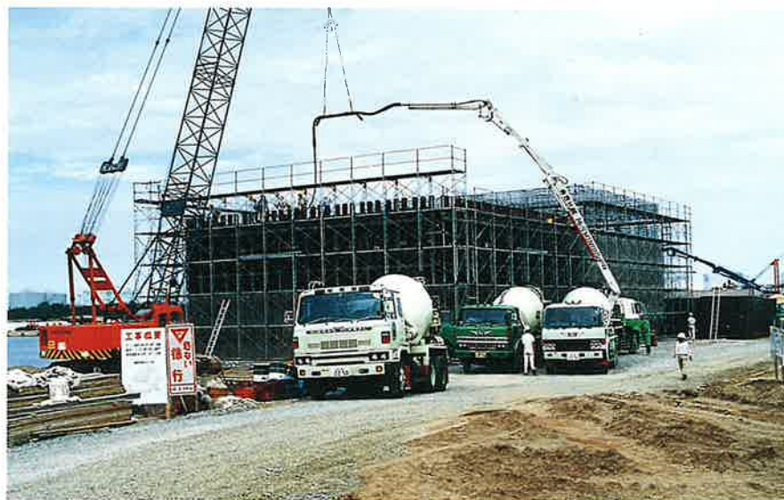
鷹巣港改修防波堤その1工事 (S62.3)
