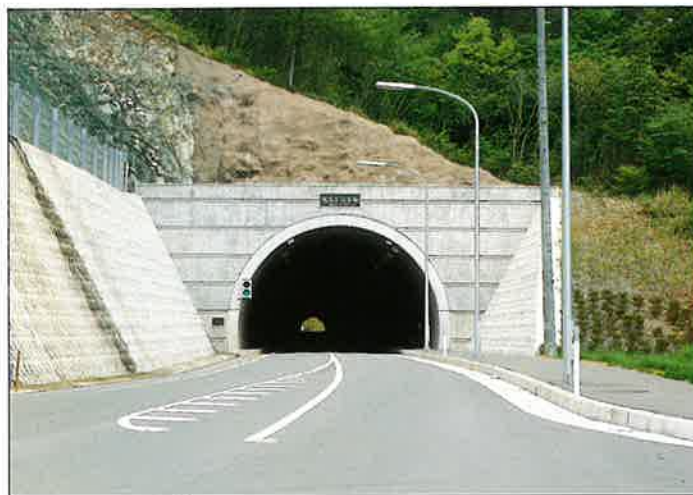
大島トンネル工事=大飯町 (1988.3) L=632M
