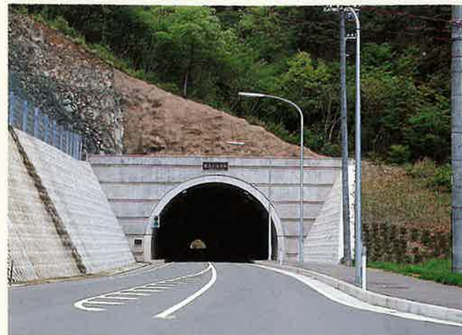
大島トンネル工事=大飯町(S63.3)/L=632M
