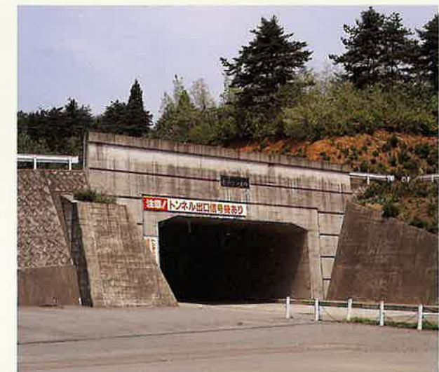
長山トンネル工事=勝山市(S59.3)/L=231M
