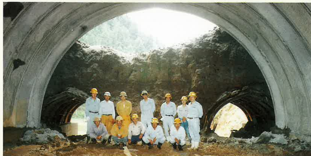
福谷第二トンネル工事=高浜町(H6.4施工中)/L=910M
