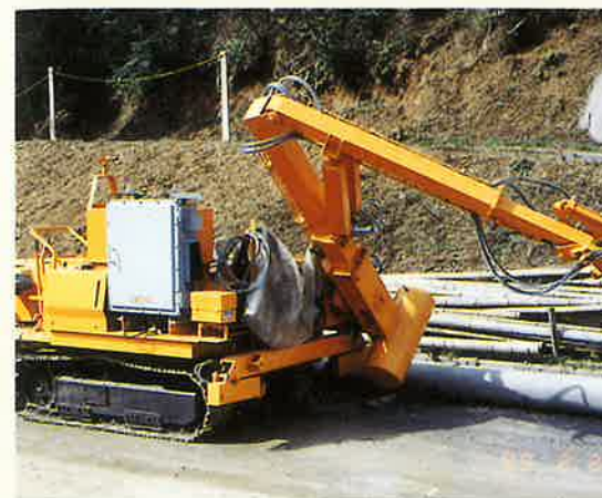
コンクリート吹付ロボット
