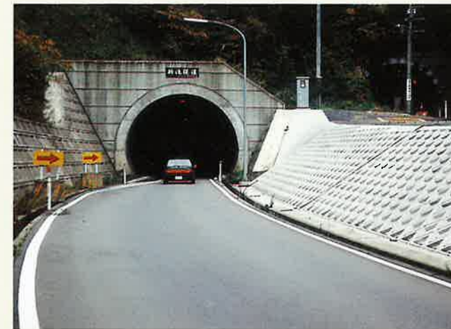
広島農道新滝トンネル工事=金津町(H2.3)/L=202M
