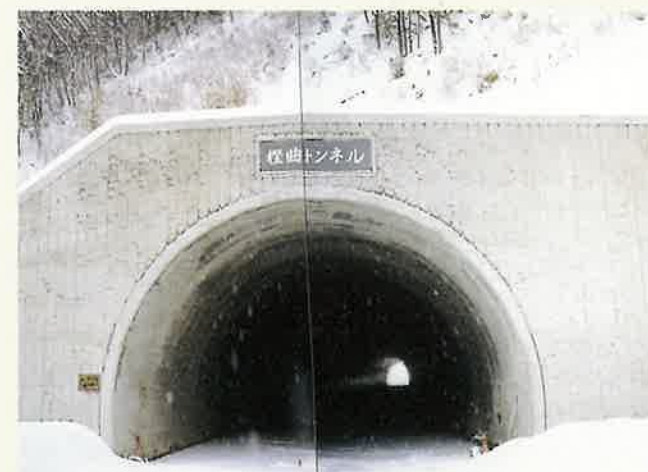
敦賀B・P 樫曲トンネル工事=敦賀市(H2.3)/L=262M
