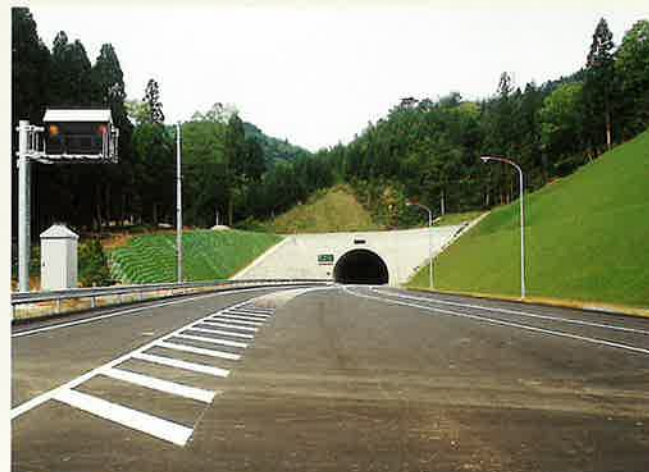
中部縦貫道・越坂トンネル工事=永平寺町(H5.3)/L=1148M
