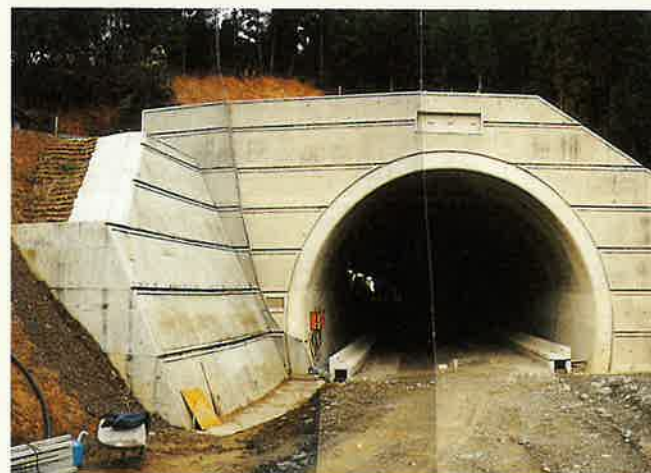
福谷第一トンネル工事=高浜町(H2.3)/L=184M
