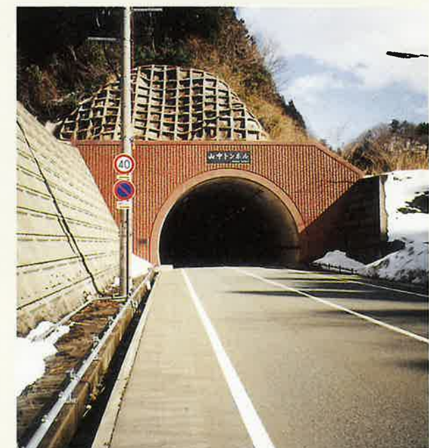
山中トンネル工事=越前町(H2.3)/L=430M(うち越前町側215M)
