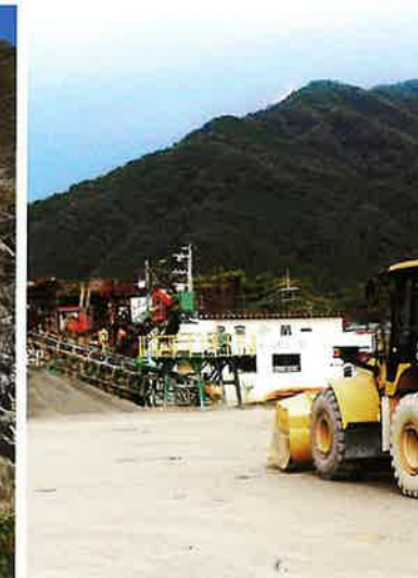
本社工場 (プラント性能) 川砂利用130t/r-1基 山碎石用100t/r-1基
