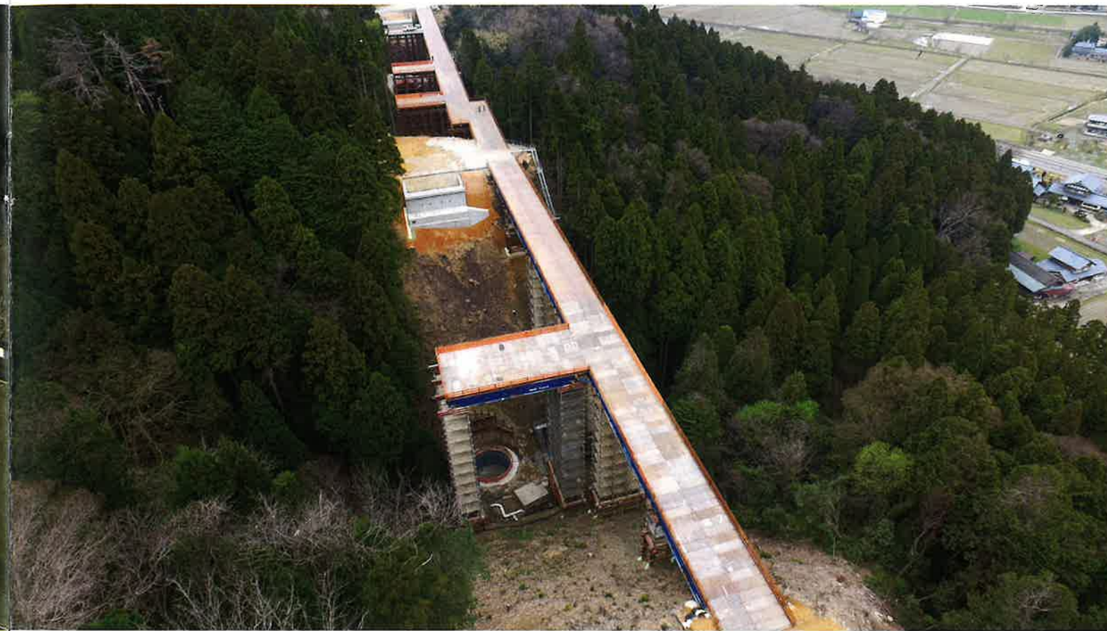
PUBLIC 1 永平寺大野道路轟3号橋下部他工事 福井県吉田郡永平寺町轟地区 2016年
