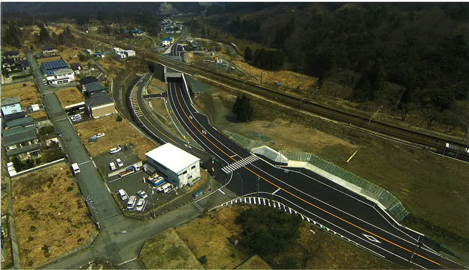
ROAD 1 愛発除雪拡幅足田地区改良工事 福井県敦賀市足田地区 2015年
