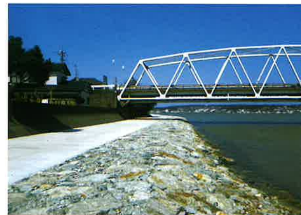
etc 2 九頭竜川新保地区護岸工事 福井県坂井市三国町新保地区 2014年
