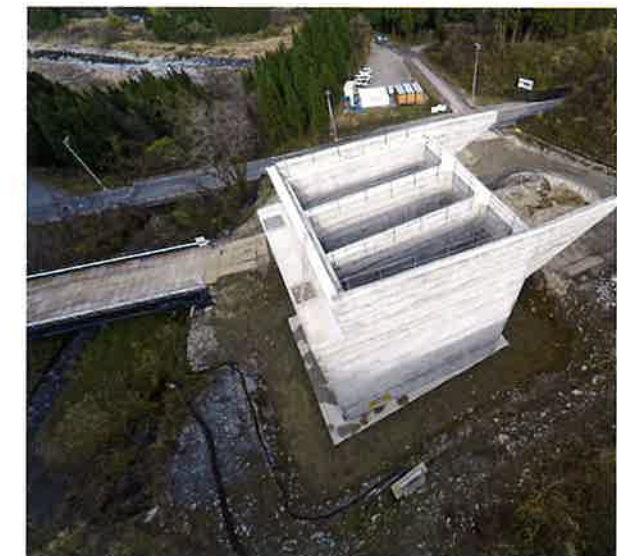
PUBLIC 3 大野油坂道路 白谷川橋A2橋台工事 福井県大野市西勝原地区 2015年
