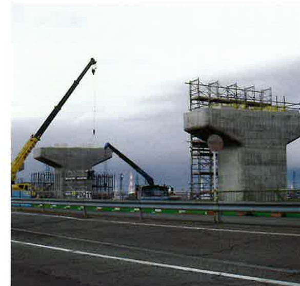
PUBLIC 2 永平寺大野道路 松岡高架橋松岡室地区下部工事 福井県吉田郡永平寺町松岡室地区 2012年
