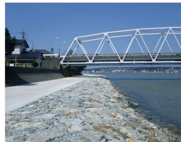
② 九頭竜川新保地区護岸工事 福井県坂井市三国町新保地区 2014年
