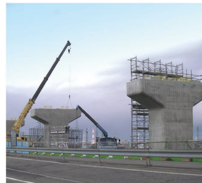
2 永平寺大野道路 松岡高架橋松岡室地区下部工事 福井県吉田郡永平寺町室地区 2012年
