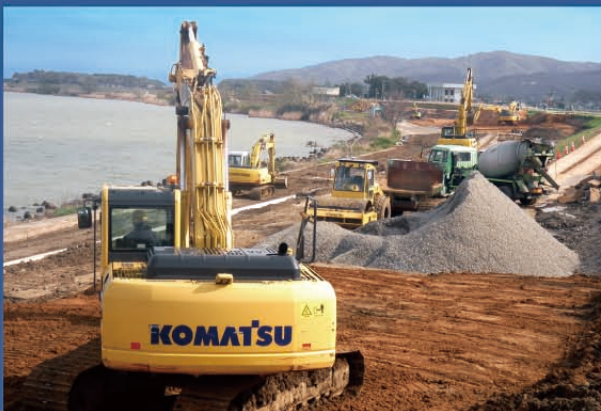
① 九頭竜川下野地区 上流堤防拡幅工事 福井県坂井市三国町 下野地区 2015年
