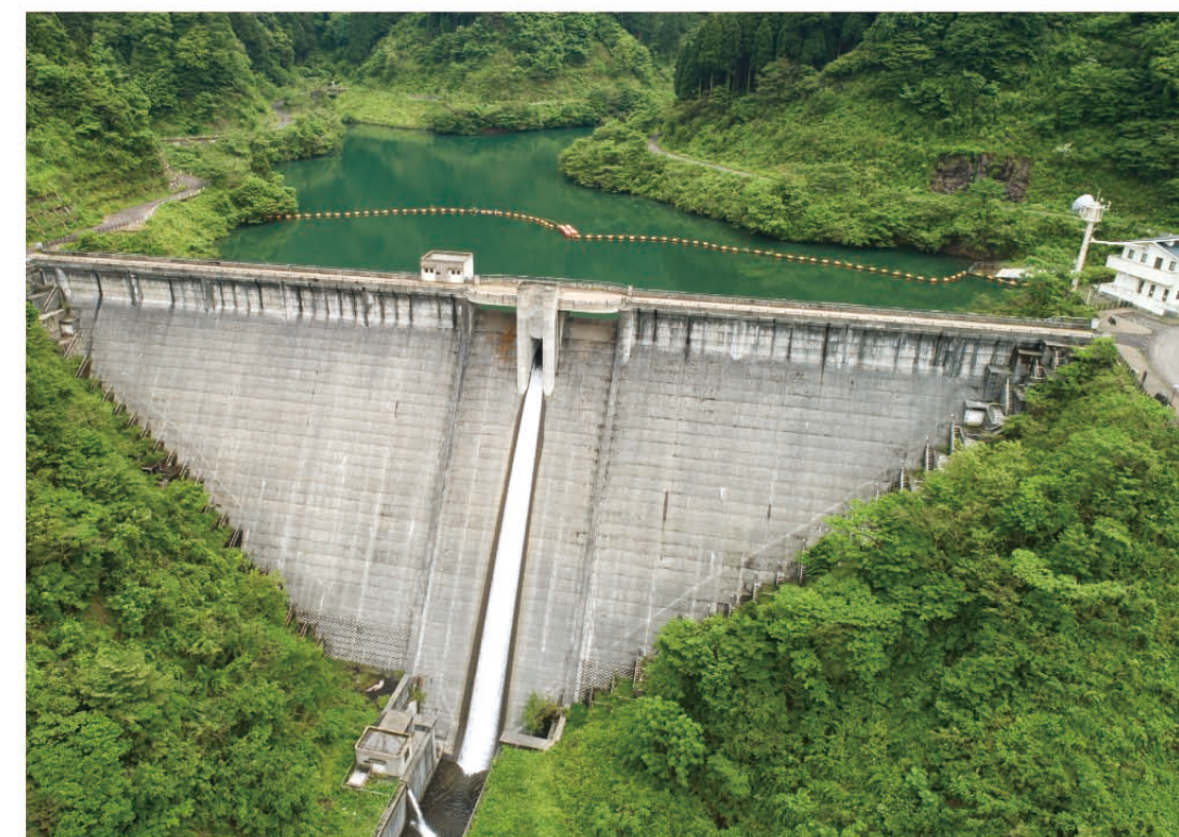
3 永平寺ダム 福井県吉田郡永平寺町 2001年竣工 ダム堤高55m ダム堤体積120,000m 3 目的:防災・工業用水・ 発電など
