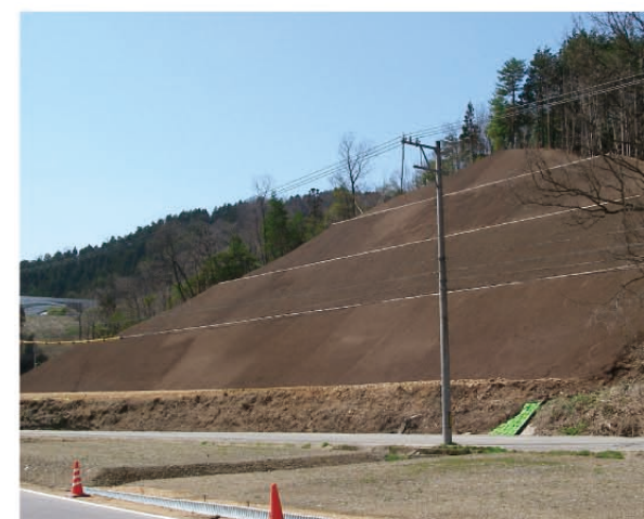
④ 福井バイパス千田地区その他改良工事 福井県坂井市丸岡町千田～ 福井県あわら市笹岡 2015年
