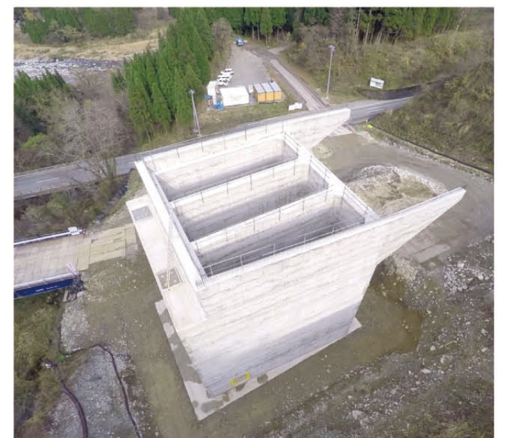
3 大野油坂道路 白谷川橋A2橋台工事 福井県大野市西勝原地区 2015年
