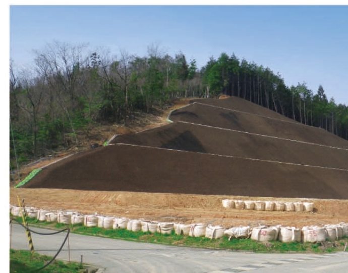
③ 福井バイパス笹岡地区他改良その他工事 福井県あわら市笹岡地区 2014年
