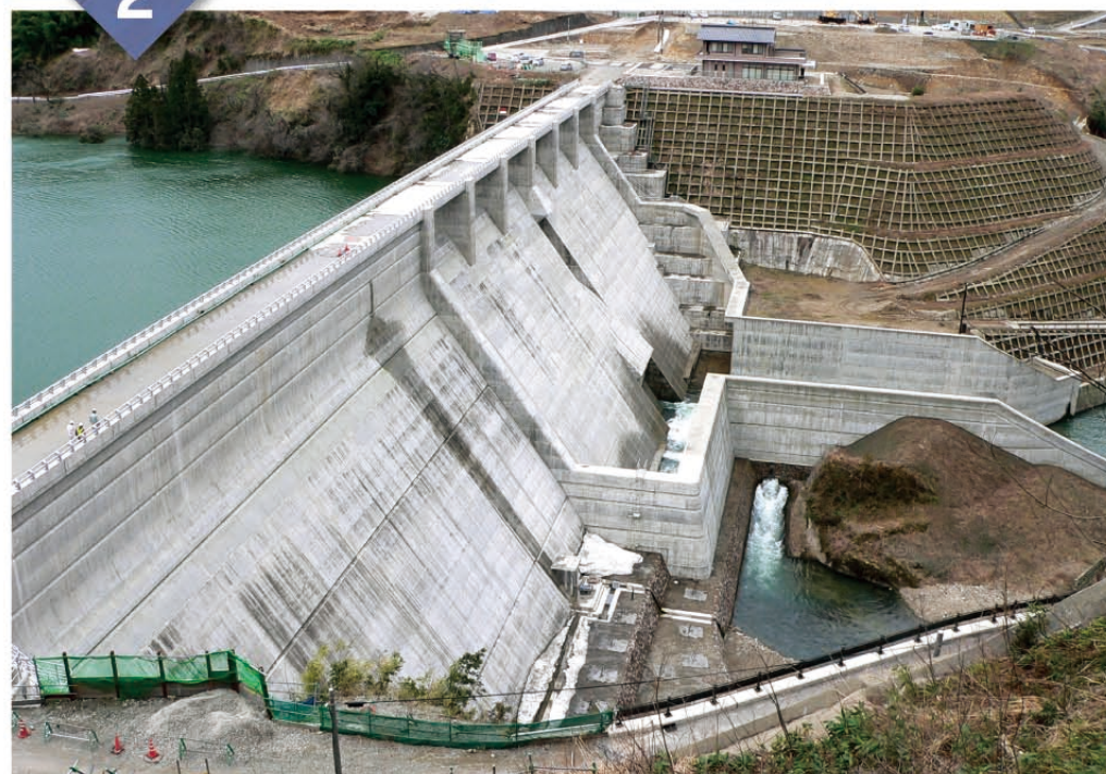
1 辰巳ダム 石川県金沢市 2012年竣工 ダム堤高50m ダム堤体積146,000m 3 目的:洪水調節・防災など
