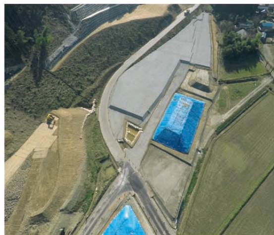
3 谷口地区道路改良工事27-2 福井県吉田郡永平寺町谷口地区 2015年
